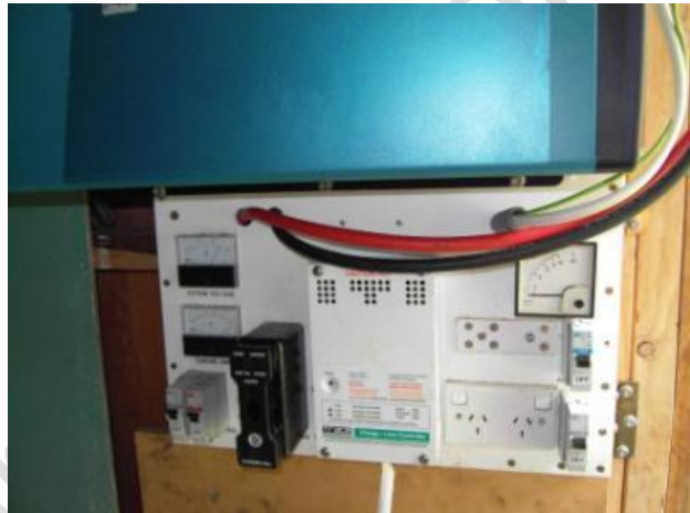
Small 24 volt system
