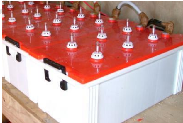
4 x 12 volt 200 amp hour Battery bank
